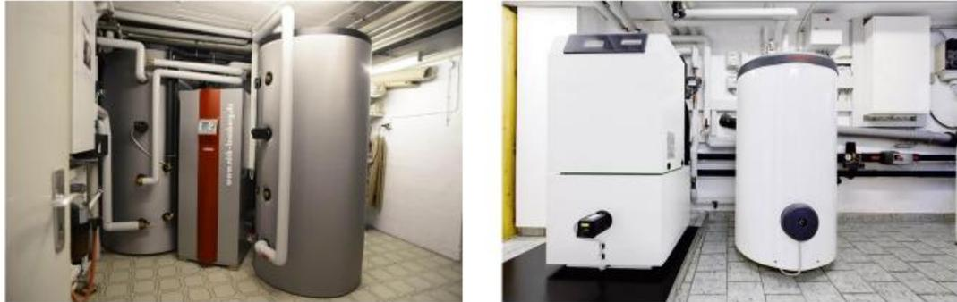
Eine Wärmepumpe kann auch dazu eingesetzt werden, dass Brauchwasser in einem Gebäude zu erwärmen. Dies kann sinnvoll sein, wenn bislang dies durch Gas- oder Ölgeräte gemacht wurde, die ebenfalls von der Heizungsanlage separat funktioniert haben. Diese Wärmepumpen können komplett in einem Kellerraum aufgestellt werden, ihnen reicht die Luft im Raum als Wärmequelle.
