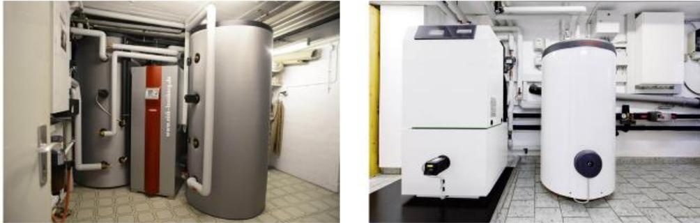
Beim Einsatz von erdgebundenen Wärmepumpen bzw. Grundwasserwärmepumpen ist die Warmwasseraufbereitung kein Problem, da aufgrund der jeweiligen Wärmequellen genügend Energie vorhanden ist. Beim Einsatz von Luftwärmepumpen kann es in längeren Kältephasen zu höheren Stromverbräuchen kommen. Denn dann sinkt die Leistung der Wärmepumpe und der Heizstab muss einspringen. Damit steigen auch die Kosten.
