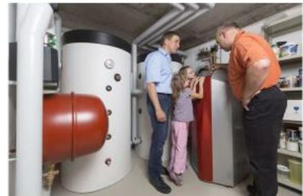
Auch für eine Wärmepumpe braucht man Platz. Die am häufigsten verbaute Wärmepumpenart ist die Luft-Wasser-Wärmepumpe. Diese gibt es in kompakter Bauform oder als Split-Gerät: Neben dem Außengerät benötigt man dann auch für das Wärmepumpeninengerät, den Pufferspeicher und den Trinkwasserspeicher Stellflächen. Ein gewisser Vorteil ist die relativ flexible Aufstellung der Geräte.
