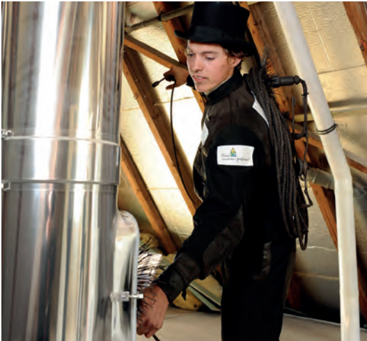
Ein Schornsteinfeger beim Kehren eines Schornsteins.
