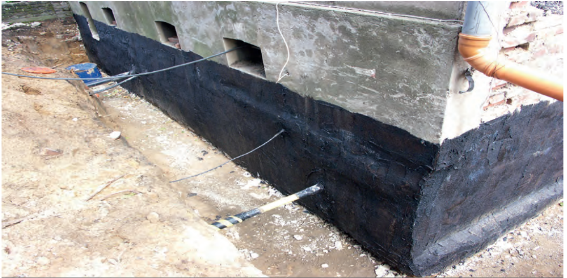
Aufwendig: Die Kellerdämmung von außen
